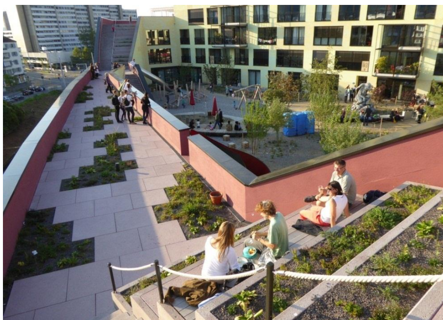
Figure 18 - Quartier Kalkbreite, Zurich
