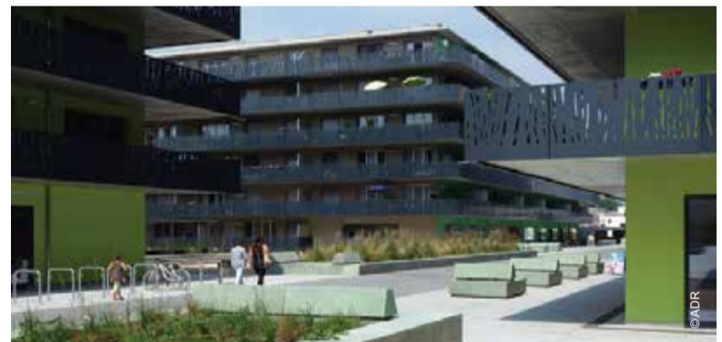
Venelles sans trafic à Vernier (ADR architectes paysagistes)
