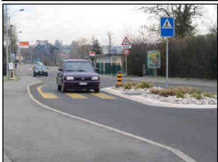
Fig.99, 100 et 101 : Cheminements piétonniers : mail du Vélodrome, chemin entre la route du Vélodrome et le Pont du Centenaire, route de Saconnex d'Arve
