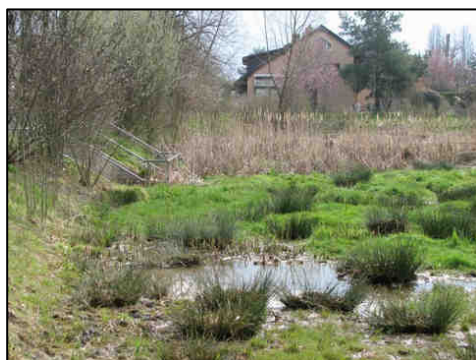
Fig.51 : Bassin de rétention de la Bistoquette
