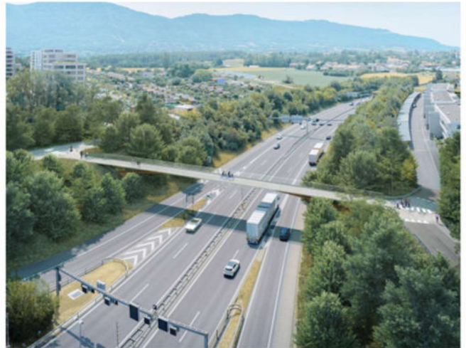
Vue aérienne au-dessus de l'A1
