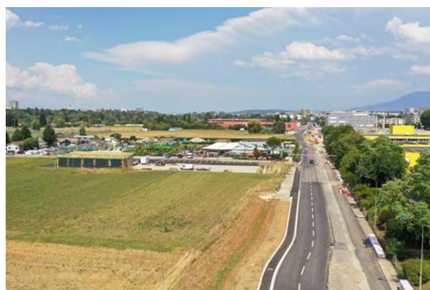
Les Cherpines - vue est - situation en août 2022
