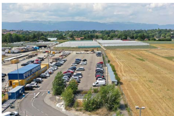
Les Cherpines - vue nord - situation en août 2022
